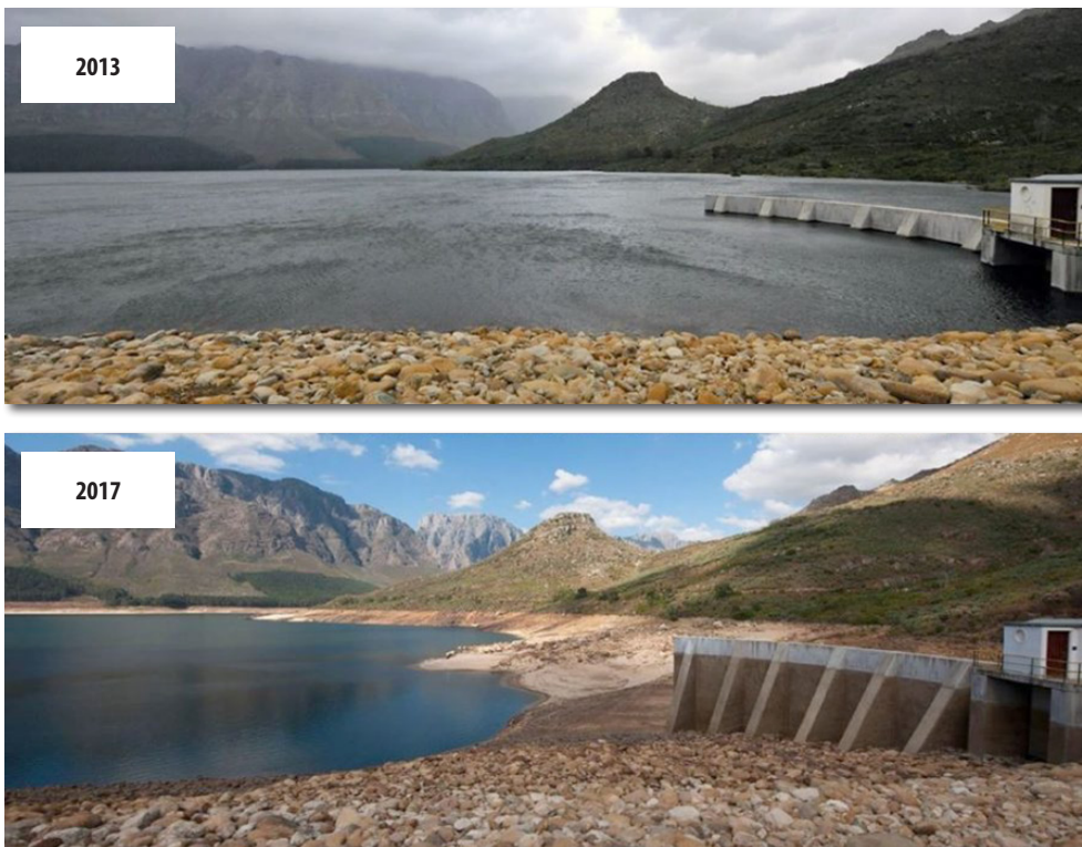
Figura 8: Descenso en el nivel de embalse entre 2013 y 2017 en Ciudad del Cabo.
